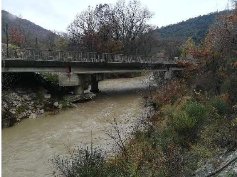
Figure 8 : Pont de la Roche (D13)
