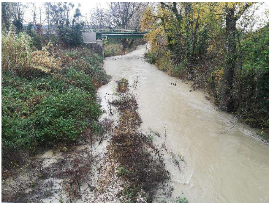
Figure 15 : Vue vers l'aval depuis le pont Vieux
