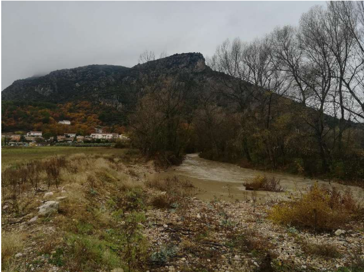
Figure 7 : Intrados coupé dans le méandre (amont traversée siphon)
