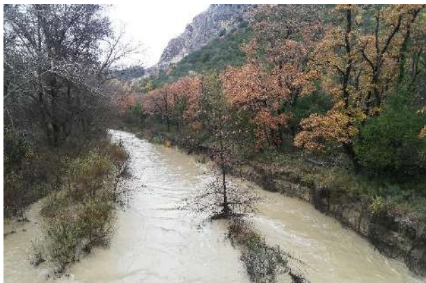
Figure 5 : vue amont depuis la passerelle de la voie verte
