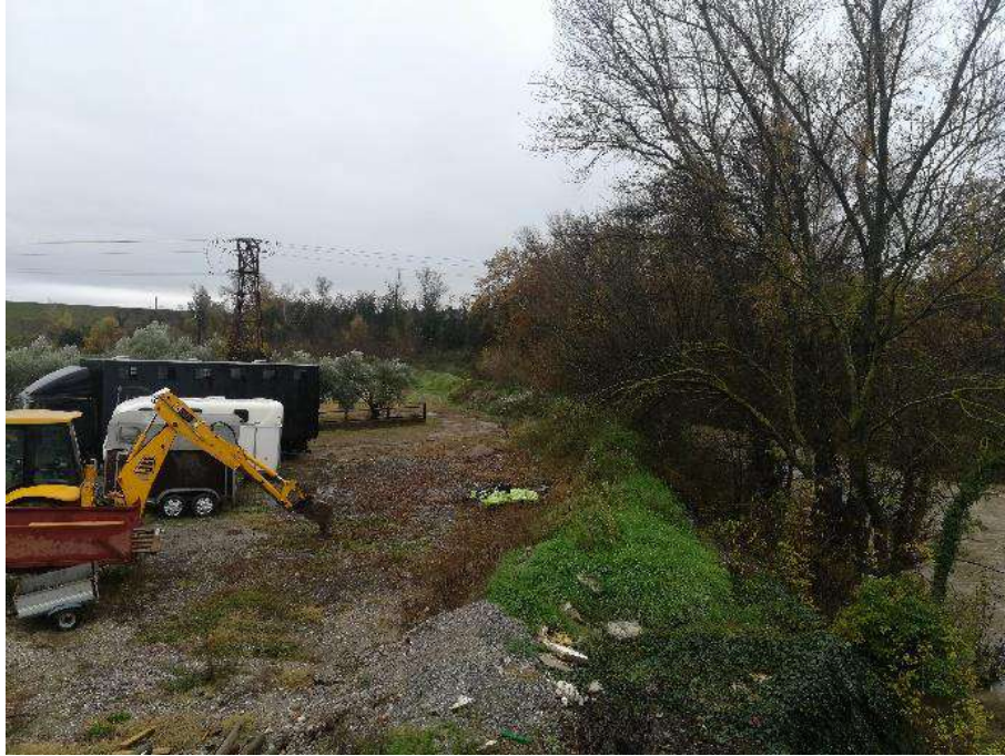
Figure 11 : Remblai du centre equestre en RG
