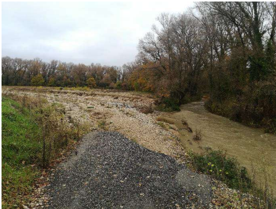
Figure 17 : Chemin rural emporté par la crue de 2019
