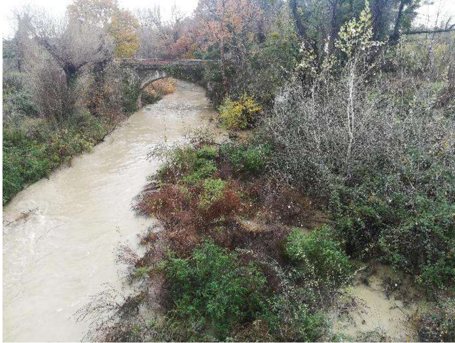
Figure 14 : Vue vers l'amont depuis le pont Vieux : canal de la Brillanne avec décharge et atterrissement en RG
